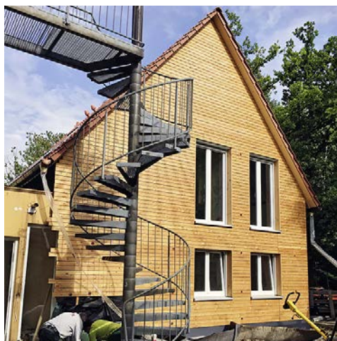
📄 Das neue Gebäude wurde als Holzständerbau errichtet, der Innenausbau ist so gut wie fertig.
